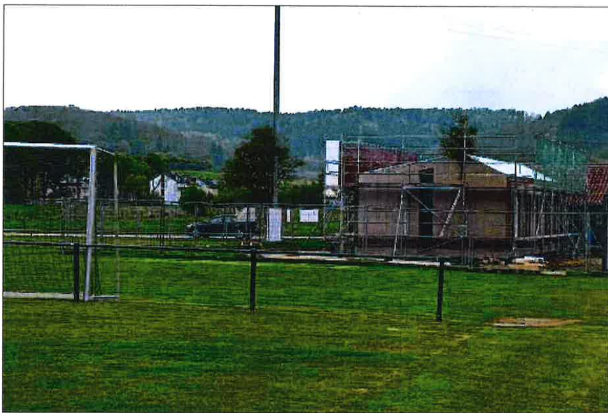
Zu den bestehenden Anlagen gesellt sich das neue Gebäude in modernster Bautechnik.
